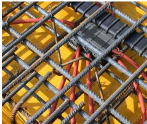
Abb. II.16: Eingelegte Leerrohre für Anschluss- und Messkabel.
