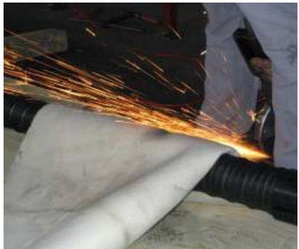
Abb. II.18: Schutzmatte z. Bsp. beim Arbeiten mit der Trennscheibe.
