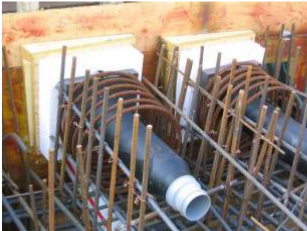
Abb. II.5: An Schalung befestigte Verankerungen.
